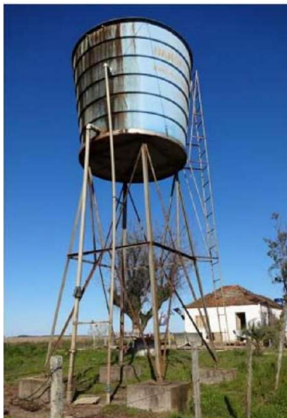
Figura 142 – Reservatório Posto Branco do Município. Fonte: PDA, 2014
