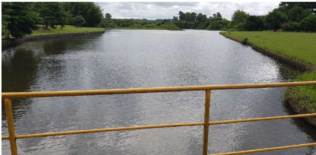
Figura 17 – Represa do Arroio Moreira. Fonte: Biancade Engenharia
