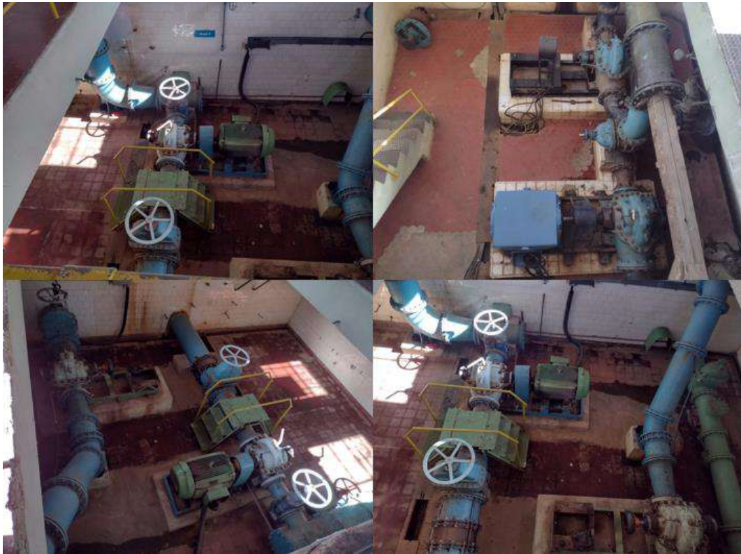
Figura 22 – Vistas dos Conjuntos Motobomba
