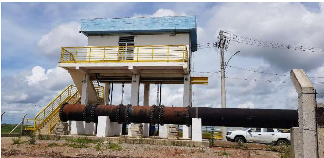
Figura 28 – Prédio com Quadros Elétricos e Adutora de Água Bruta. Fonte: Biancade Engenharia
