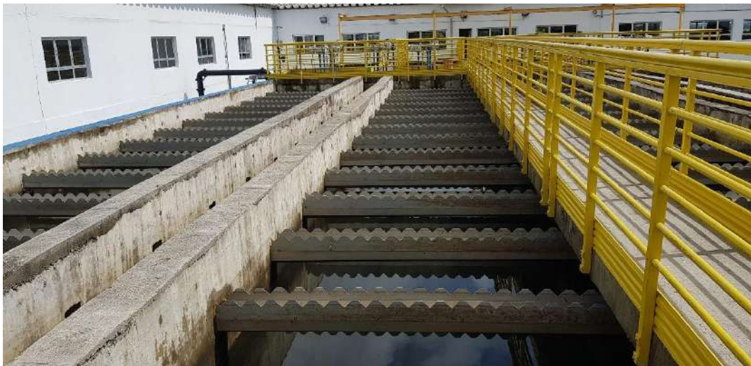
Figura 79 – Decantadores. Fonte: Biancade Engenharia
