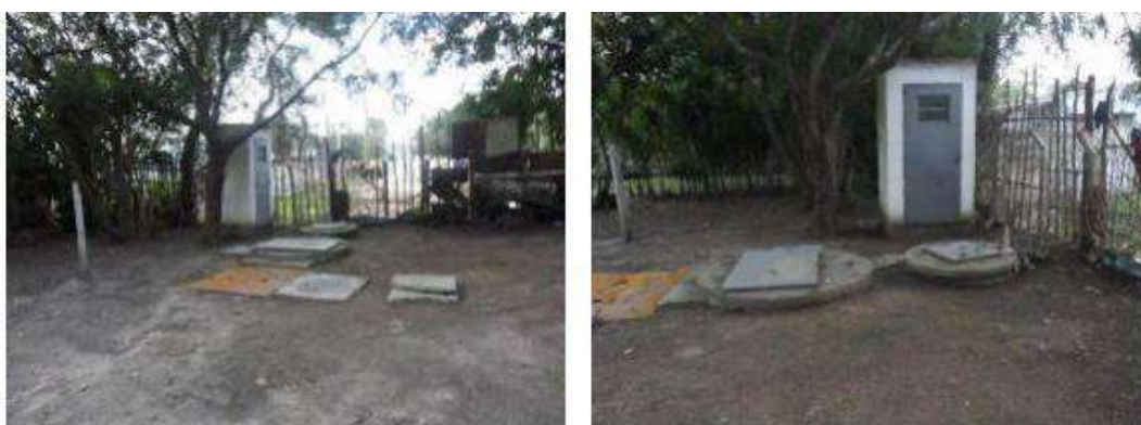
Figura 213 – EEE Vila Castilho – Estação Elevatória Vila Castilho. Fonte: PDE, 2011
