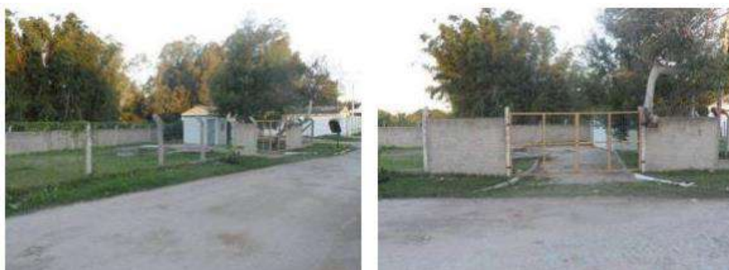
Figura 215 – EEE Cohab Fragata – Estação Elevatória Cohab Fragata. Fonte: PDE, 2011
