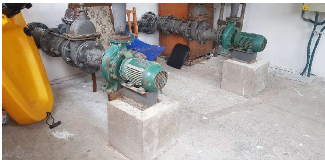
Figura 125 – Conjunto de Motobombas do Reservatório R-12. Fonte: Biancade Engenharia
