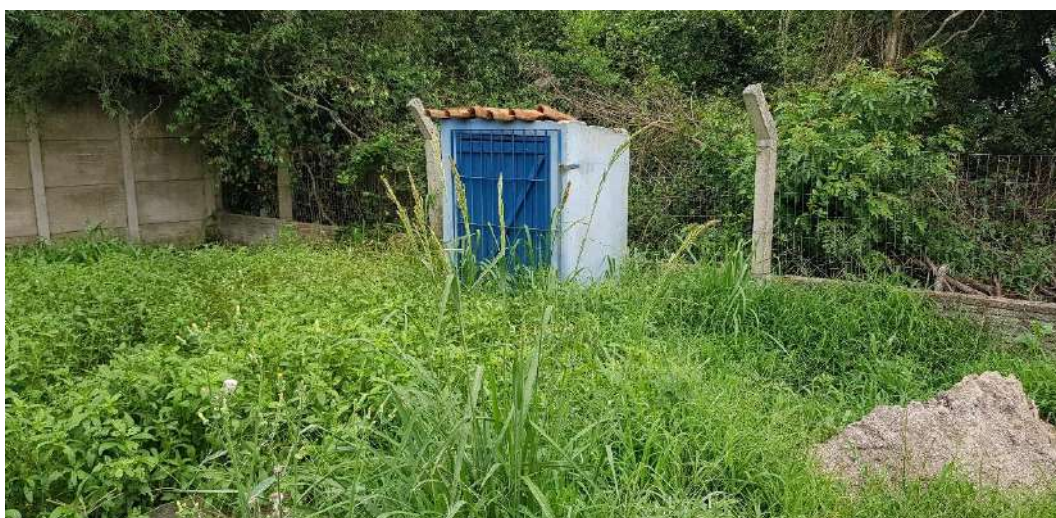
Figura 200 – Estação Elevatória Vila Judite. Fonte: Biancade Engenharia
