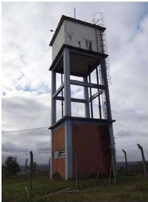
Figura 140 – Reservatórios para regularização de vazão. Fonte: PDA, 2014
