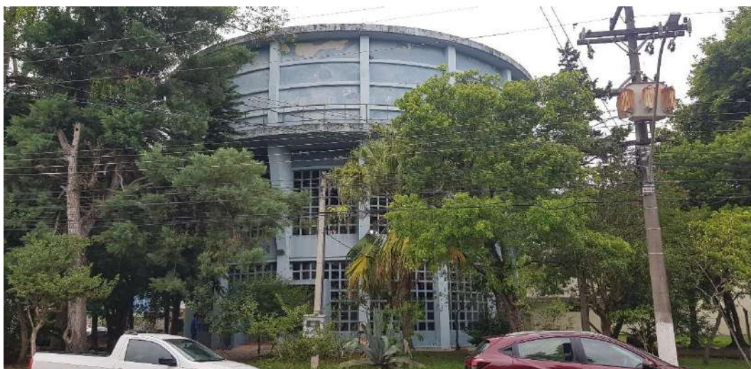
Figura 117 – Exterior do Reservatório R-04 do Município. Fonte: Biancade Engenharia
