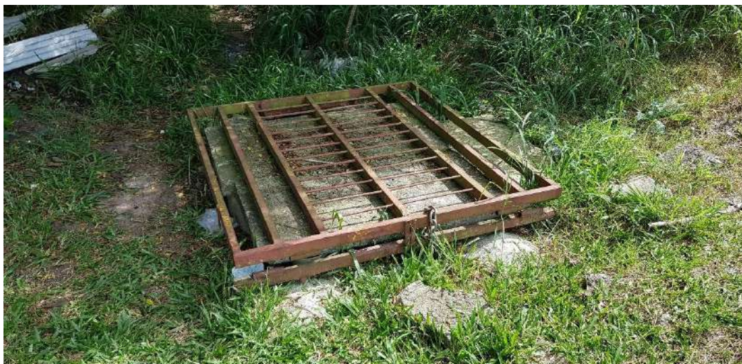
Figura 204 – Estação Elevatória Rodoviária. Fonte: PDE, 2011
