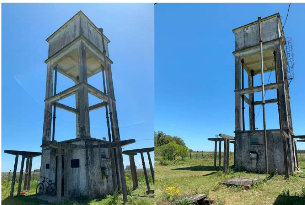
Figura 134 – Reservatório R-13 Elevado do Município. Fonte: PDA, 2014
