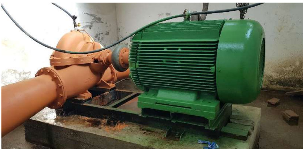
Figura 108 – Bomba da EEAT 3. Fonte: Biancade Engenharia
