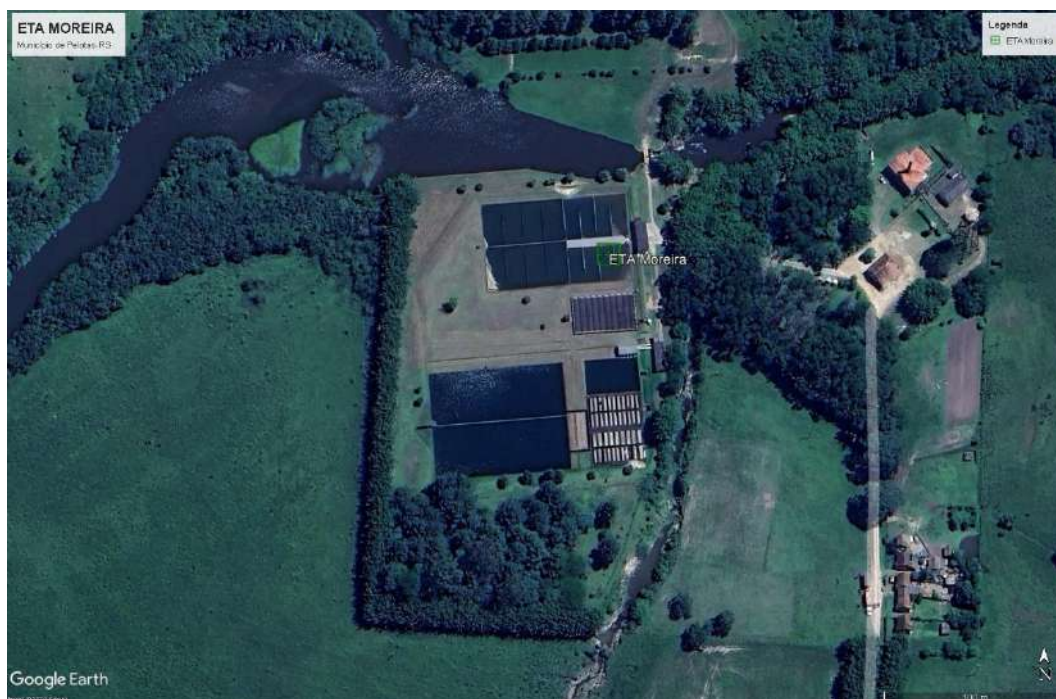
Figura 31 – Localização da ETA Moreira. Fonte: Google Earth
