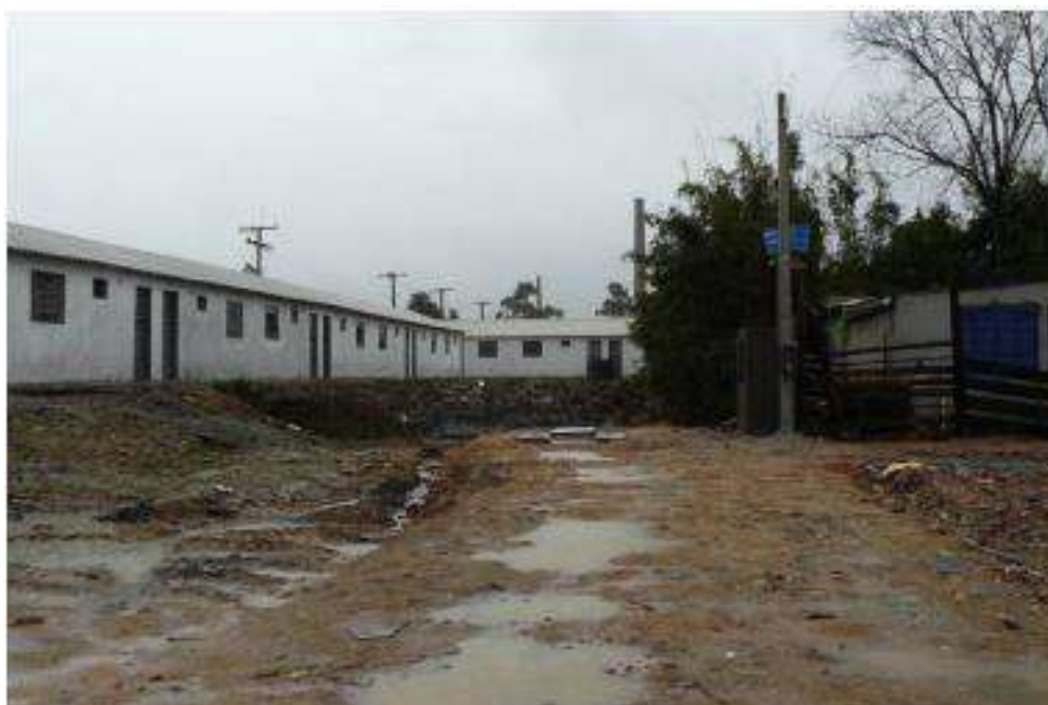
Figura 219 – EEE General Osorio – Estação Elevatória General Osorio. Fonte: PDE, 2011
