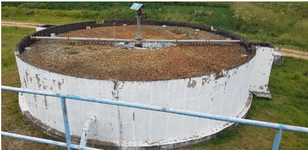
Figura 159 – ETE Laranjal – Vista Superior Filtro Biológico. Fonte: Biancade Engenharia
