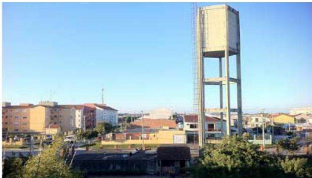
Figura 136 – Reservatório Jardim das Tradições Elevado do Município. Fonte: PDA, 2014
