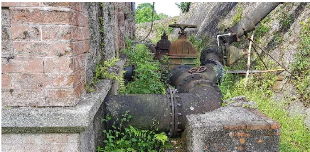
Figura 88 – Adutora Existente no Município. Fonte: Biancade Engenharia
