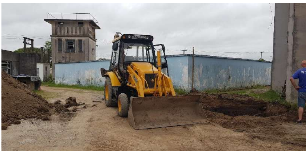
Figura 119 – Reservatório Enterrado R-08 do Município. Fonte: Biancade Engenharia
