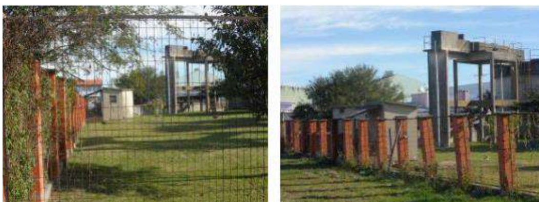
Figura 224 – EEE Jardim das Tradições – Estação Elevatória Jardim das Tradições. Fonte: PDE, 2011
