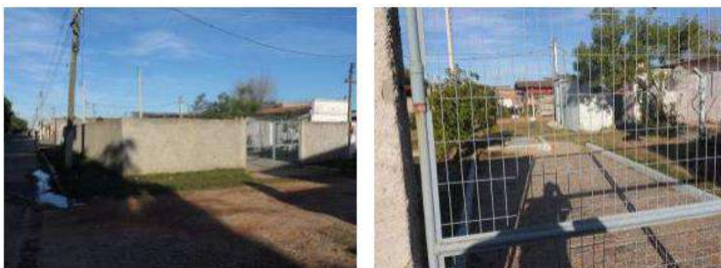
Figura 208 – EEE Navegantes II – Estação Elevatória Navegantes II. Fonte: PDE, 2011
