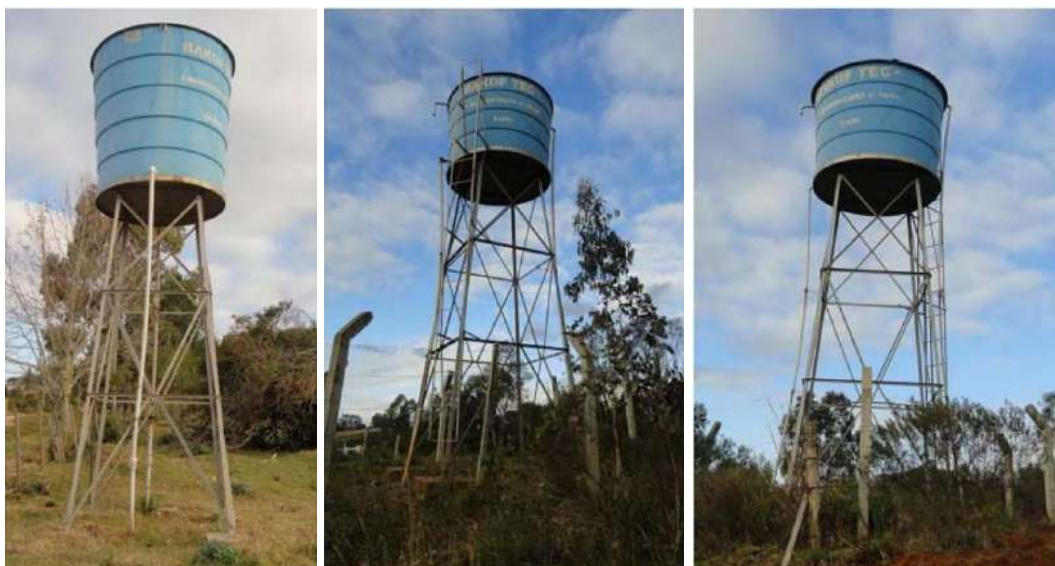
Figura 140 – Reservatórios para regularização de vazão. Fonte: PDA, 2014
