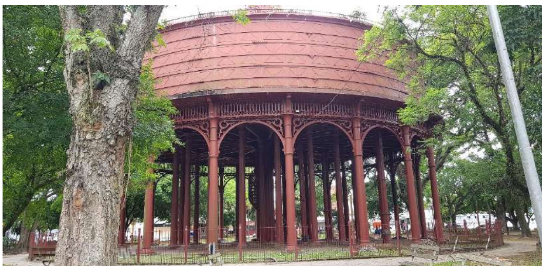
Figura 114 – Reservatório R-01 do Município. Fonte: Biancade Engenharia
