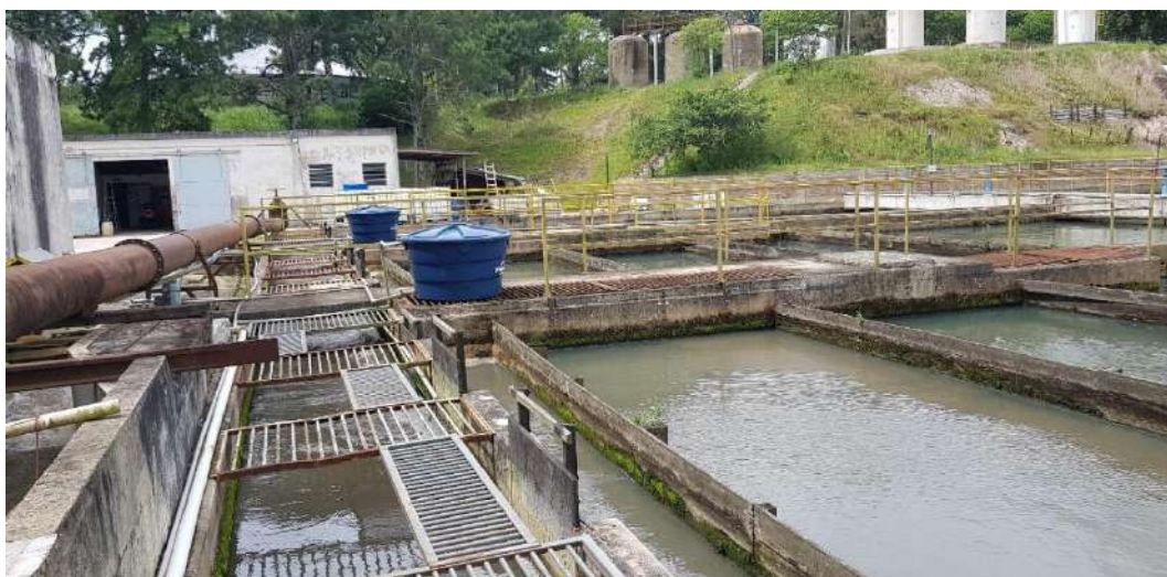
Figura 45 – Decantadores Canal 2 de Entrada da Estação de Tratamento. Fonte: Biancade Engenharia
