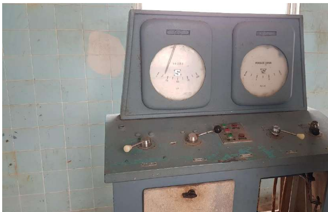
Figura 49 – Bancada de Operação para Limpeza dos Filtros. Fonte: Biancade Engenharia
