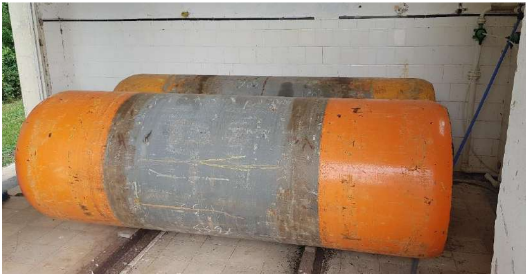
Figura 37 – Cilindros de Cloro. Fonte: Biancade Engenharia
