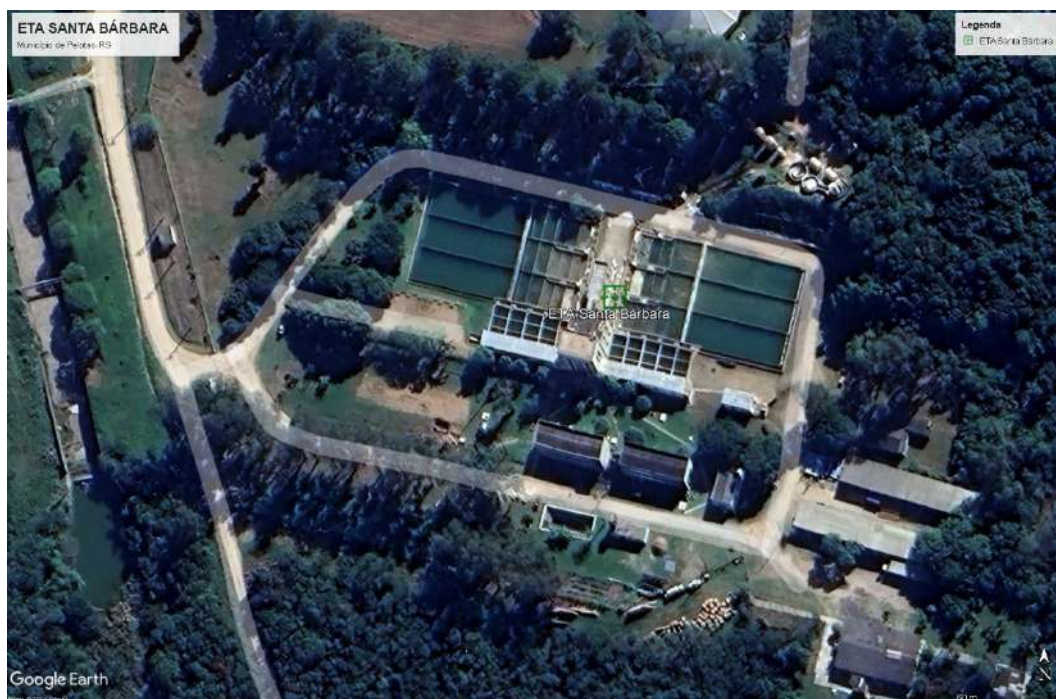
Figura 41 – Localização da ETA Santa Bárbara. Fonte: Google Earth
