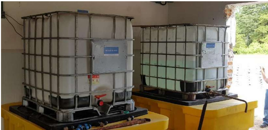
Figura 67 – Hidróxido de Sódio da ETA Sinnot. Fonte: Biancade Engenharia
