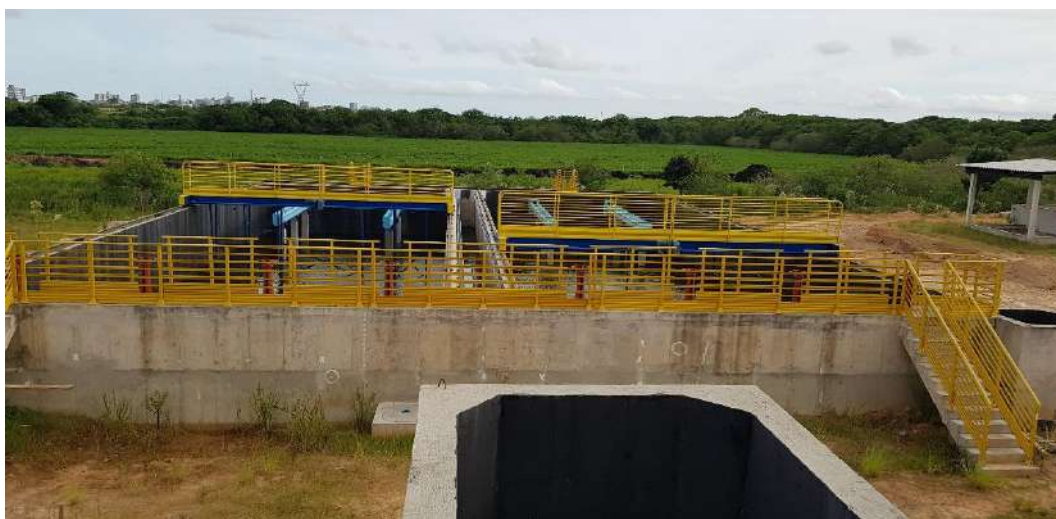
Figura 168 – ETE Novo Mundo – Decantadores. Fonte: Biancade Engenharia
