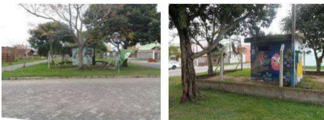
Figura 209 – EEE Umuharama – Estação Elevatória Umuharama. Fonte: PDE, 2011
