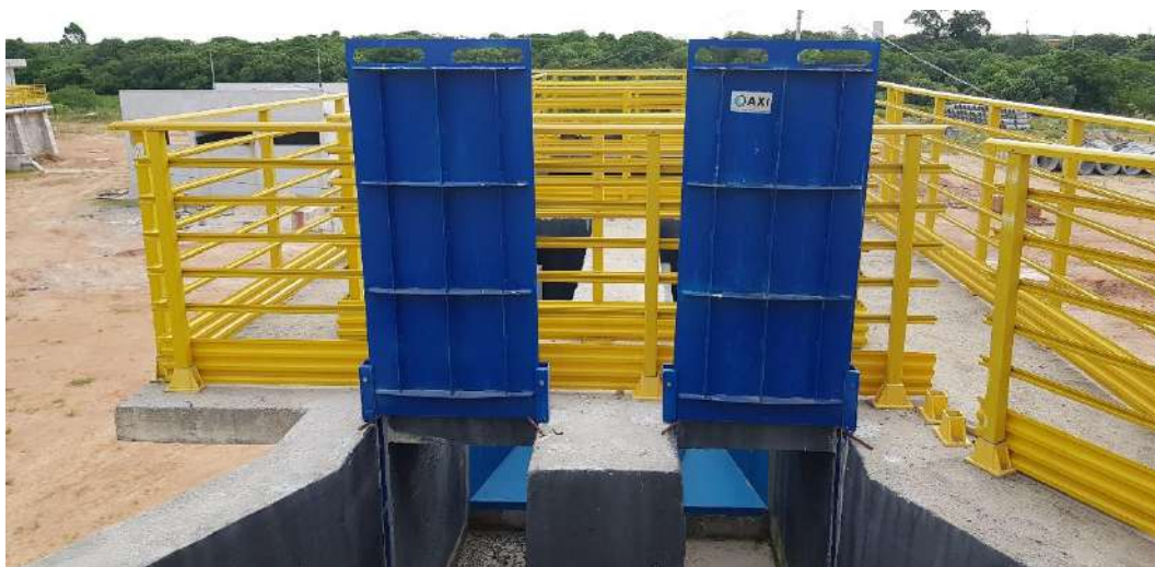
Figura 166 – ETE Novo Mundo – Comportas. Fonte: Biancade Engenharia
