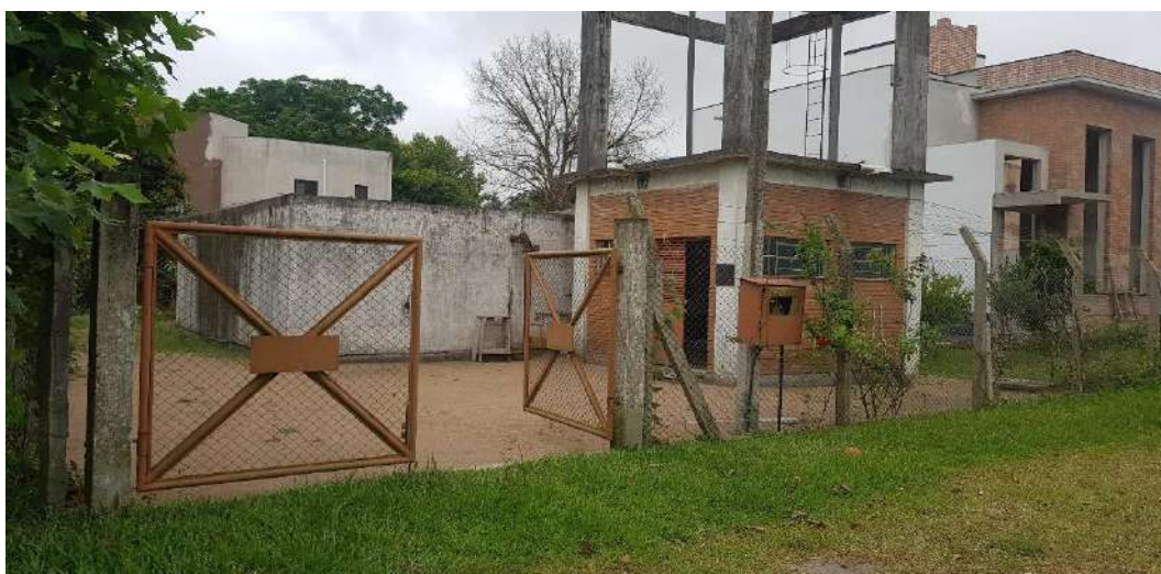
Figura 123 – Reservatório Semi Enterrado R-12 do Município. Fonte: Biancade Engenharia
