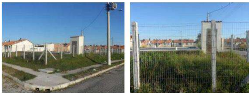
Figura 218 – EEE Eldorado – Estação Elevatória Eldorado. Fonte: PDE, 2011
