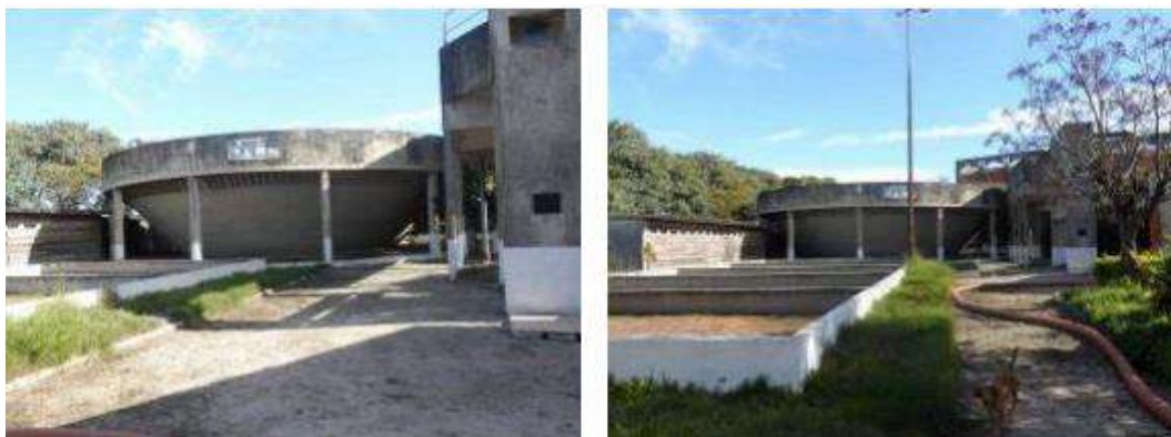
Figura 225 – EEE US-III – Estação Elevatória US-III. Fonte: PDE, 2011
