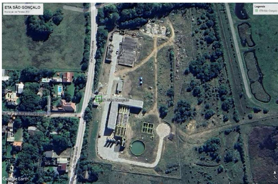
Figura 71 – Localização da ETA São Gonçalo. Fonte: Google Earth
