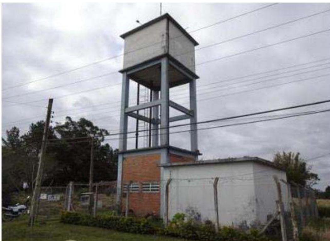
Figura 138 – Reservatório MB-2 do Município. Fonte: PDA, 2014
