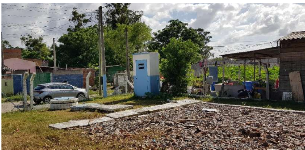
Figura 198 – EEE Ceval – Estação Elevatória Ceval. Fonte: PDE, 2011
