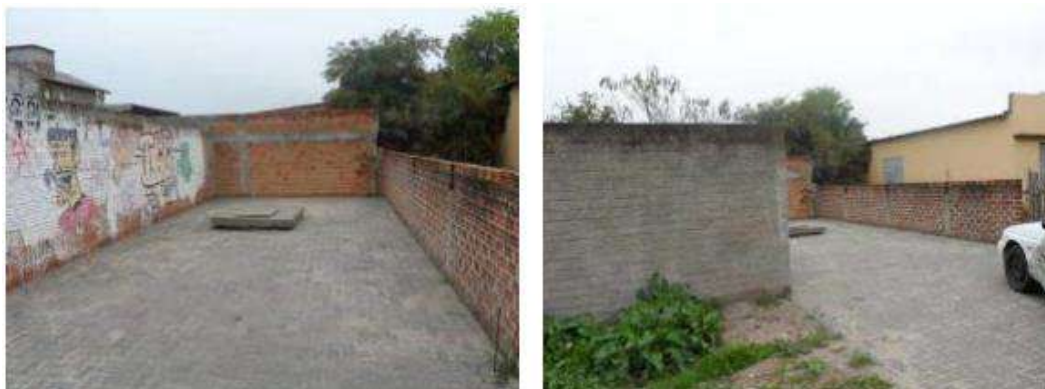
Figura 223 – EEE Toussaint – Estação Elevatória Toussaint. Fonte: PDE, 2011
