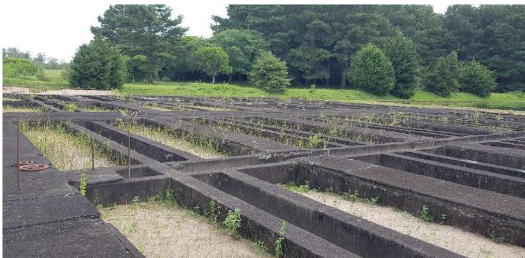
Figura 35 – Antigos Filtros Horizontais. Fonte: Biancade Engenharia
