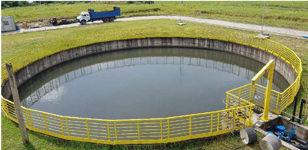
Figura 77 – Adensador. Fonte: Biancade Engenharia
