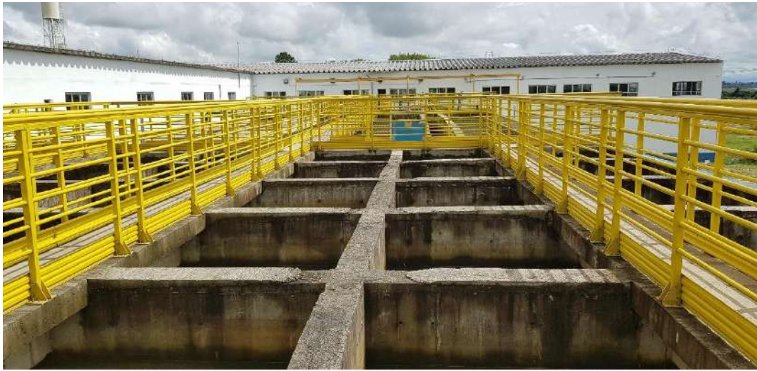
Figura 79 – Decantadores. Fonte: Biancade Engenharia
