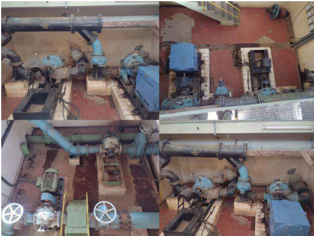
Figura 22 – Vistas dos Conjuntos Motobomba
