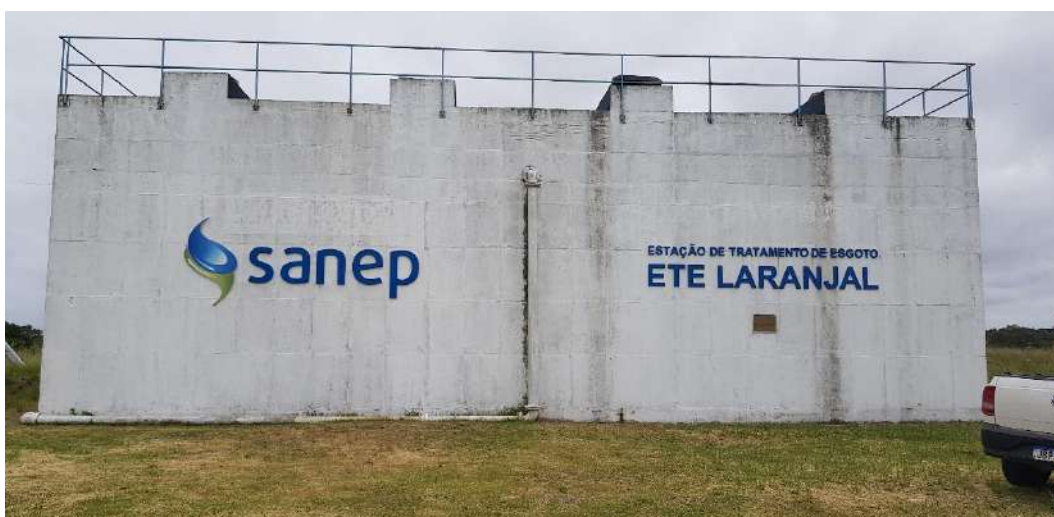
Figura 155 – ETE Laranjal – Reator Anaeróbio. Fonte: Biancade Engenharia
