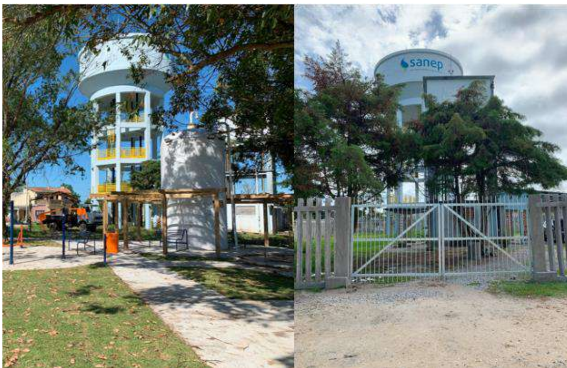
Figura 133 – Reservatório R-11 e R11T do Município
