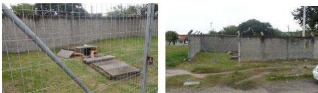
Figura 211 – EEE Cohab Lindóia – Estação Elevatória Cohab Lindóia. Fonte: PDE, 2011
