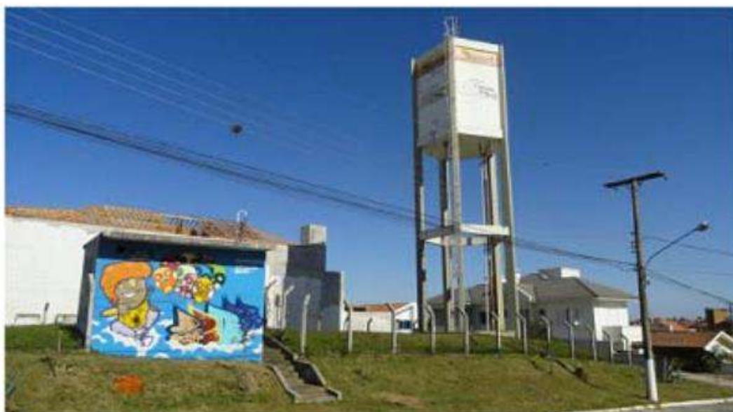
Figura 135 – Reservatório Colina do Sol Elevado do Município. Fonte: PDA, 2014
