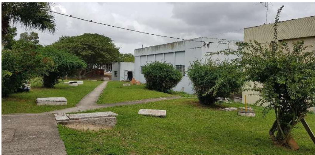
Figura 56 – Local dos Reservatórios Enterrados da ETA. Fonte: Biancade Engenharia
