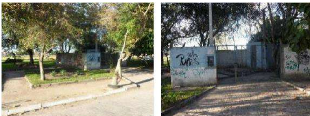
Figura 207 – EEE Ambrósio Peret – Estação Elevatória Ambrósio Peret. Fonte: PDE, 2011
