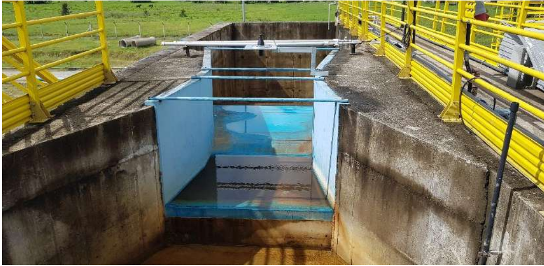
Figura 74 – Calha Parshall. Fonte: Biancade Engenharia
