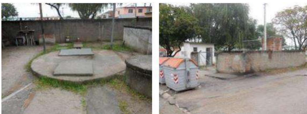
Figura 214 – EEE Guabiroba – Estação Elevatória Guabiroba. Fonte: PDE, 2011
