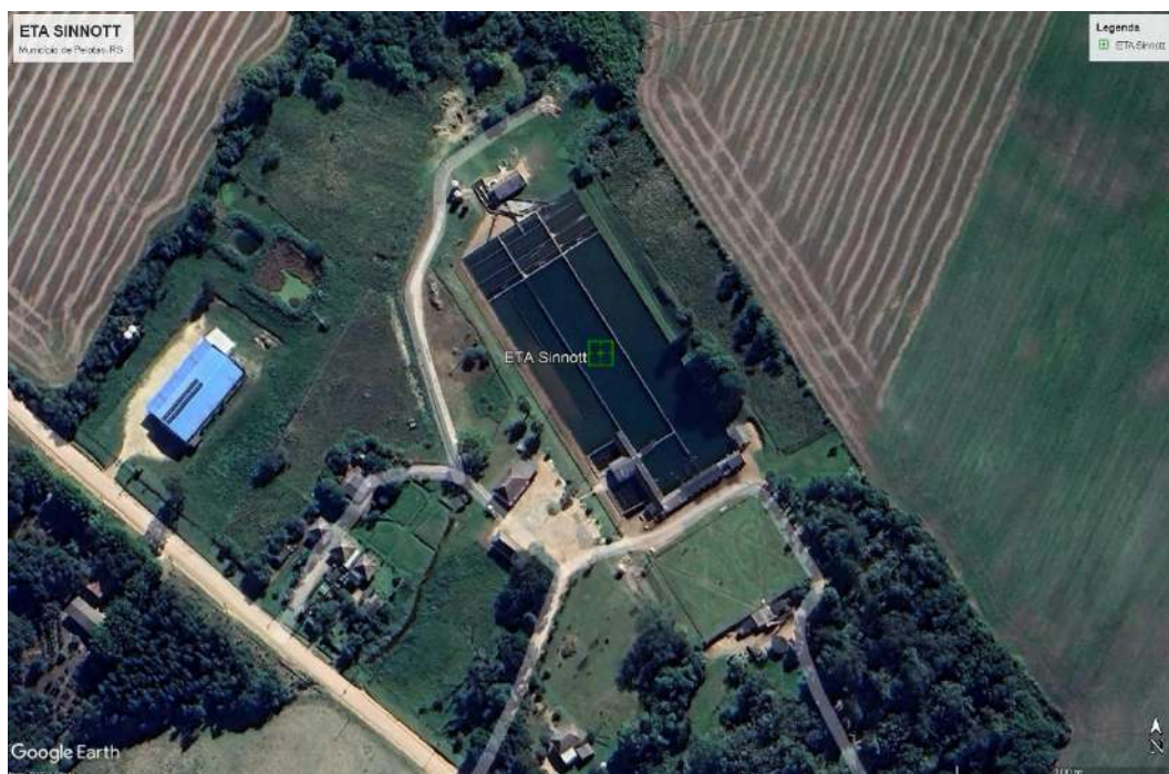
Figura 57 – Localização da ETA Sinnott. Fonte: Google Earth
