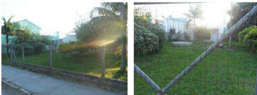
Figura 210 – EEE Cohab Tablada – Estação Elevatória Cohab Tablada. Fonte: PDE, 2011
