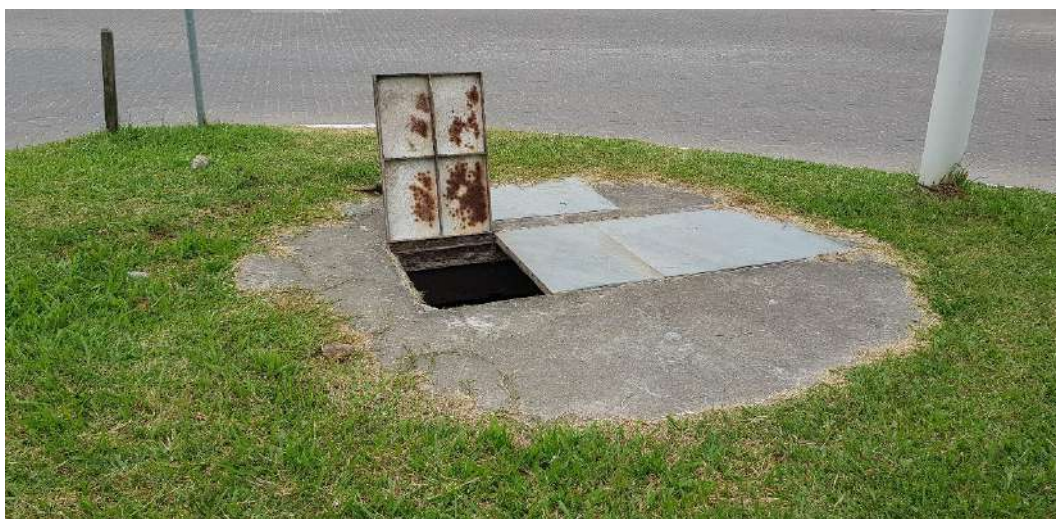
Figura 183 – EEE L3 – Entrada do Poço de Sucção. Fonte: Biancade Engenharia
