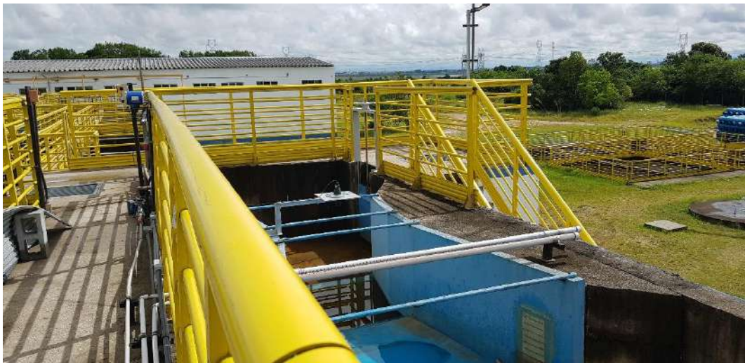
Figura 74 – Calha Parshall. Fonte: Biancade Engenharia
