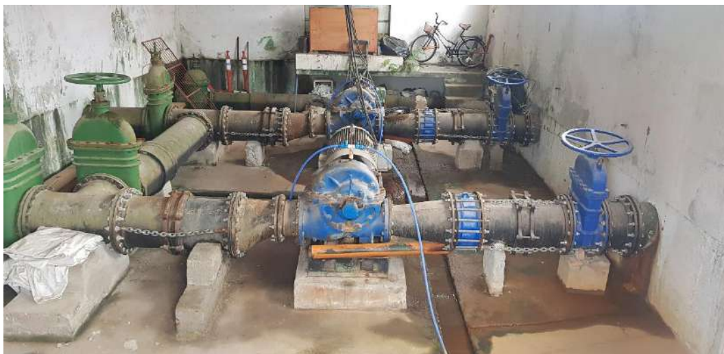
Figura 121 – Conjunto Motobombas do R-08T. Fonte: Biancade Engenharia
