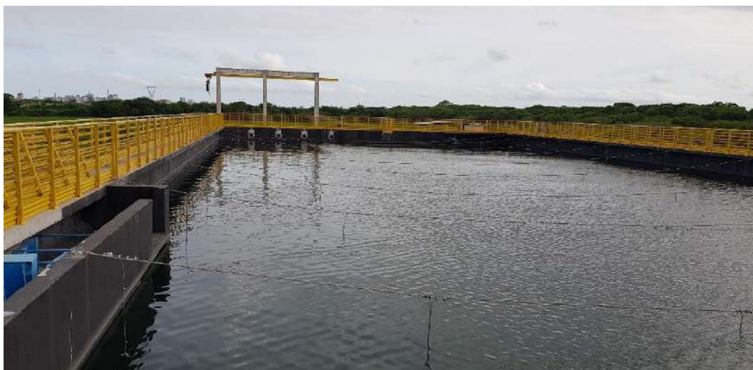
Figura 168 – ETE Novo Mundo – Decantadores. Fonte: Biancade Engenharia
