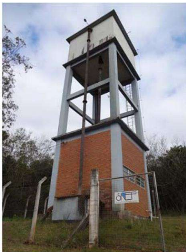
Figura 137 – Reservatório MB-1 do Município. Fonte: PDA, 2014
